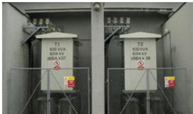
TMC-Transformátory, TMCRES-S, 630 kVA, 6/0,4 kV-AES Bohemia
